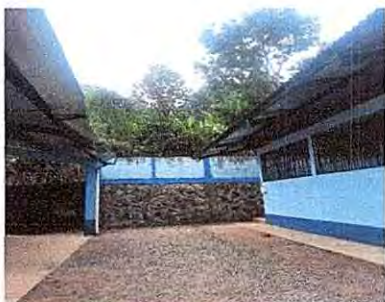
Foto 3: Tuberías de agua pluvial en mal estado
